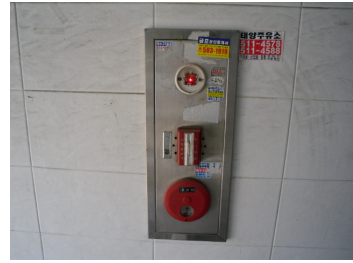
▲ 위치표시등의 파손을 방지한 경우
