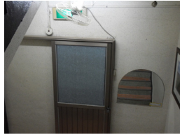
▲ 장애물로 인한 유도등의 식별이 제한되는 경우
