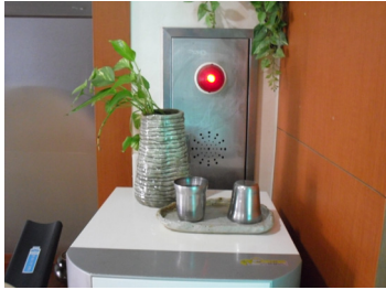
▲ 적재물로 인하여 소방시설의 사용이 제한되는 경우
